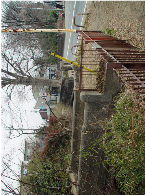
レンガアーチ橋の旧牟礼橋(手前)と牟礼橋 その先は道路に・・・
